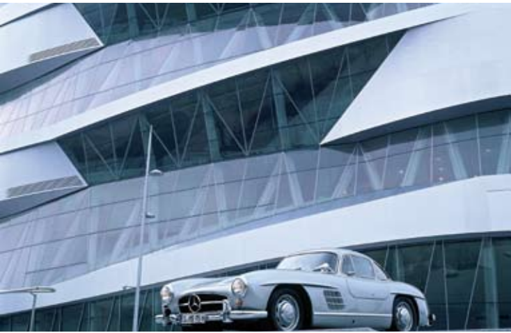
Bild 10: „PYRAN®S“ – Brandschutzverglasung im Mercedes-Benz-Automuseum, Stuttgart [24].
