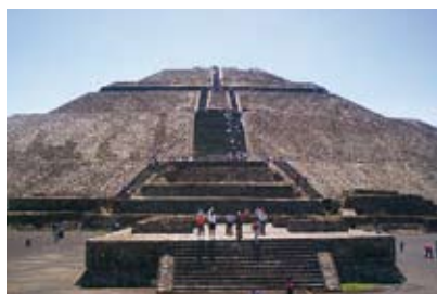
Bild 3: (Vor-)aztekische Lehmbauweise – die „Sonnenpyramide im mexikanischen Bundesstaat Mexico, die drittgrößte (!) Pyramide der Welt (63 m hoch, Grundriss-Abmessungen 222 x 225 m) mit dem voluminösen Treppenaufgang wurde vor 2.000 Jahren ebenfalls mit Stampflehm bzw. mit luftgetrockneten „Adobe“-Lehmziegeln gebaut.
