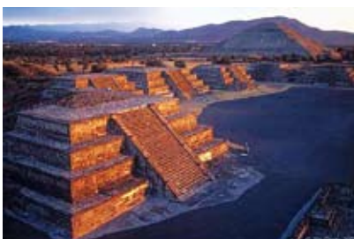
Bild 3: (Vor-)aztekische Lehmbauweise – die „Sonnenpyramide im mexikanischen Bundesstaat Mexico, die drittgrößte (!) Pyramide der Welt (63 m hoch, Grundriss-Abmessungen 222 x 225 m) mit dem voluminösen Treppenaufgang wurde vor 2.000 Jahren ebenfalls mit Stampflehm bzw. mit luftgetrockneten „Adobe“-Lehmziegeln gebaut.
